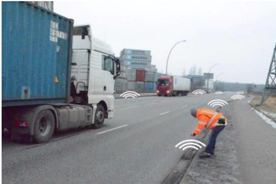
Abb. 1: Schwarmsensoren sollen Systemzustände im Regen- und Mischwassernetz erkennen und den Betrieb verbessern helfen.
